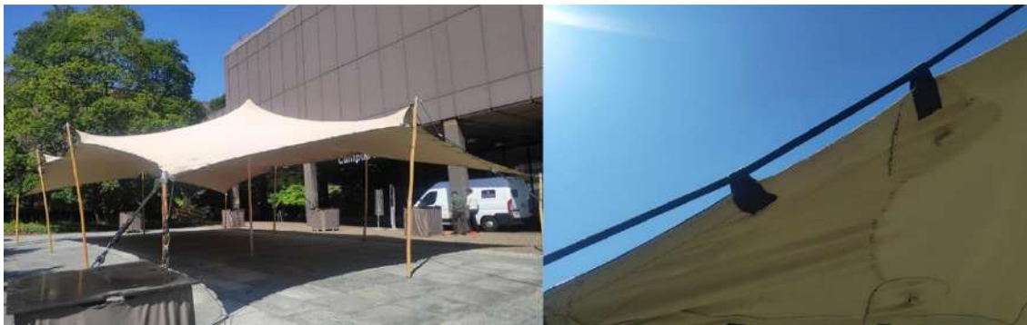
Grafika 19. Przykładowy model połączenia podpory sztywnej z modelem membranowym. Analogiczny problem łączenia występuje na połączeniu podpory z powłoką. Ze względu na sztywny charakter powłoki w badanym modelu nie występuje potrzeba stężania krawędzi, która w powłokach membranowych stanowi kluczowy element zachowania geometrii.
