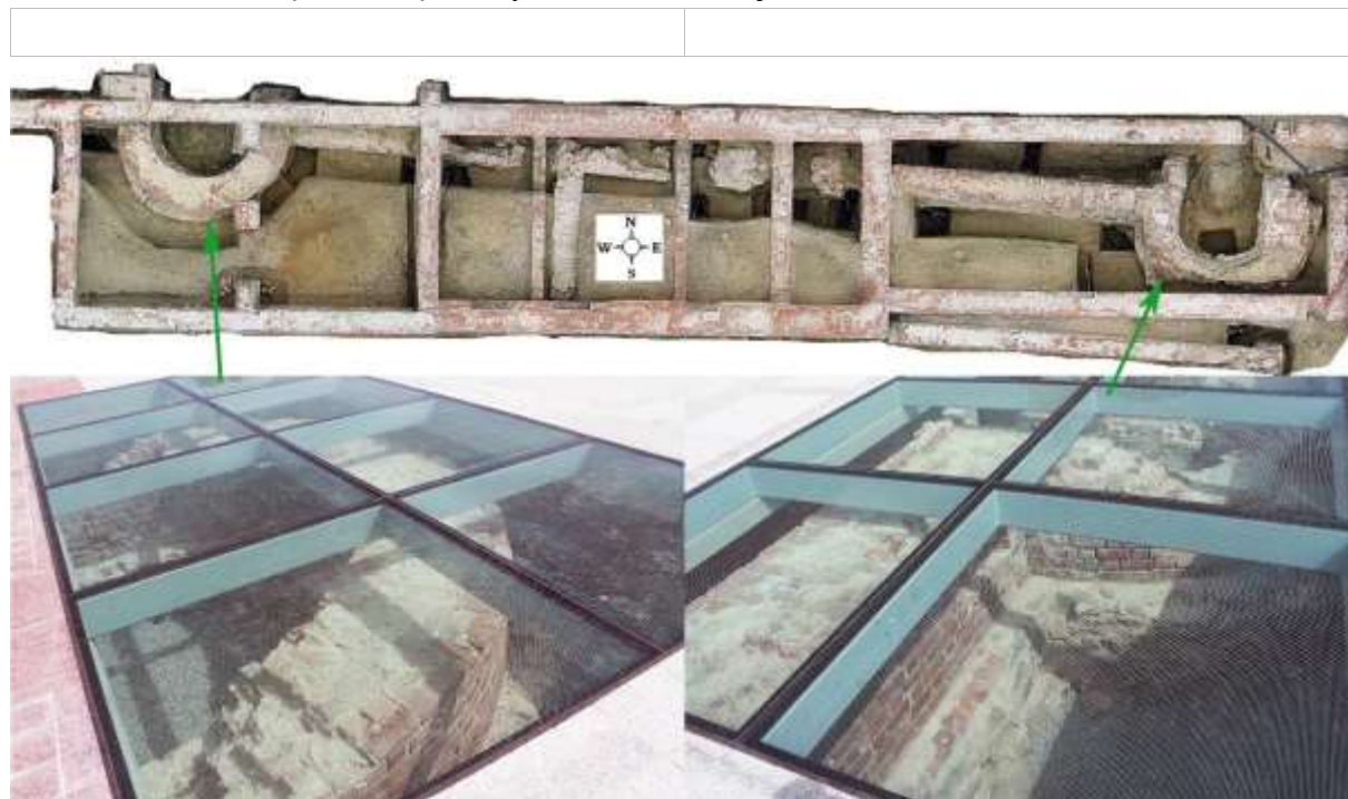
Ryc. 17. Wrocław, pl. Wolności. Ortofotorelikwii XIV-wiecznego obwodu obronnego (u góry) i ekspozycję pod szkłem odkrytych baszt łupinowych o przekroju półkolistym.
