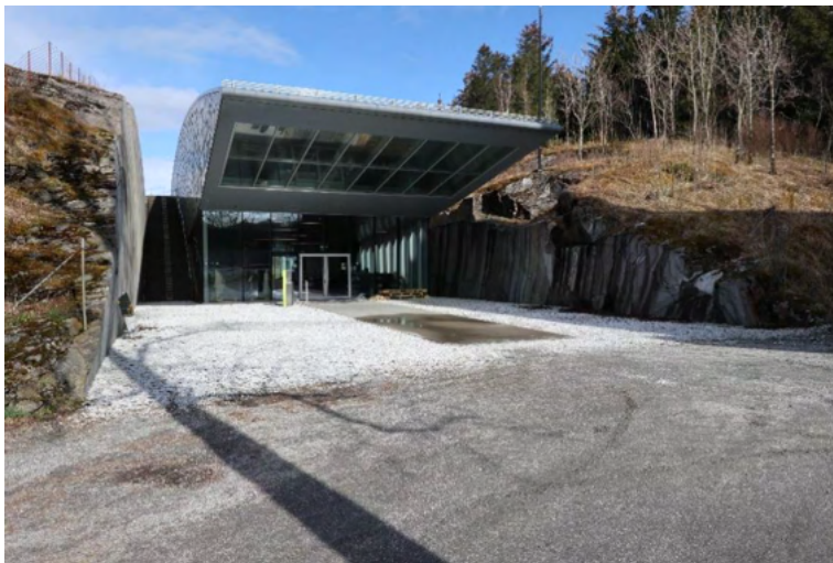
Il. 71. Muzeum Pettera Dassa, widok od strony wejścia głównego. Fot. autora, 2022
