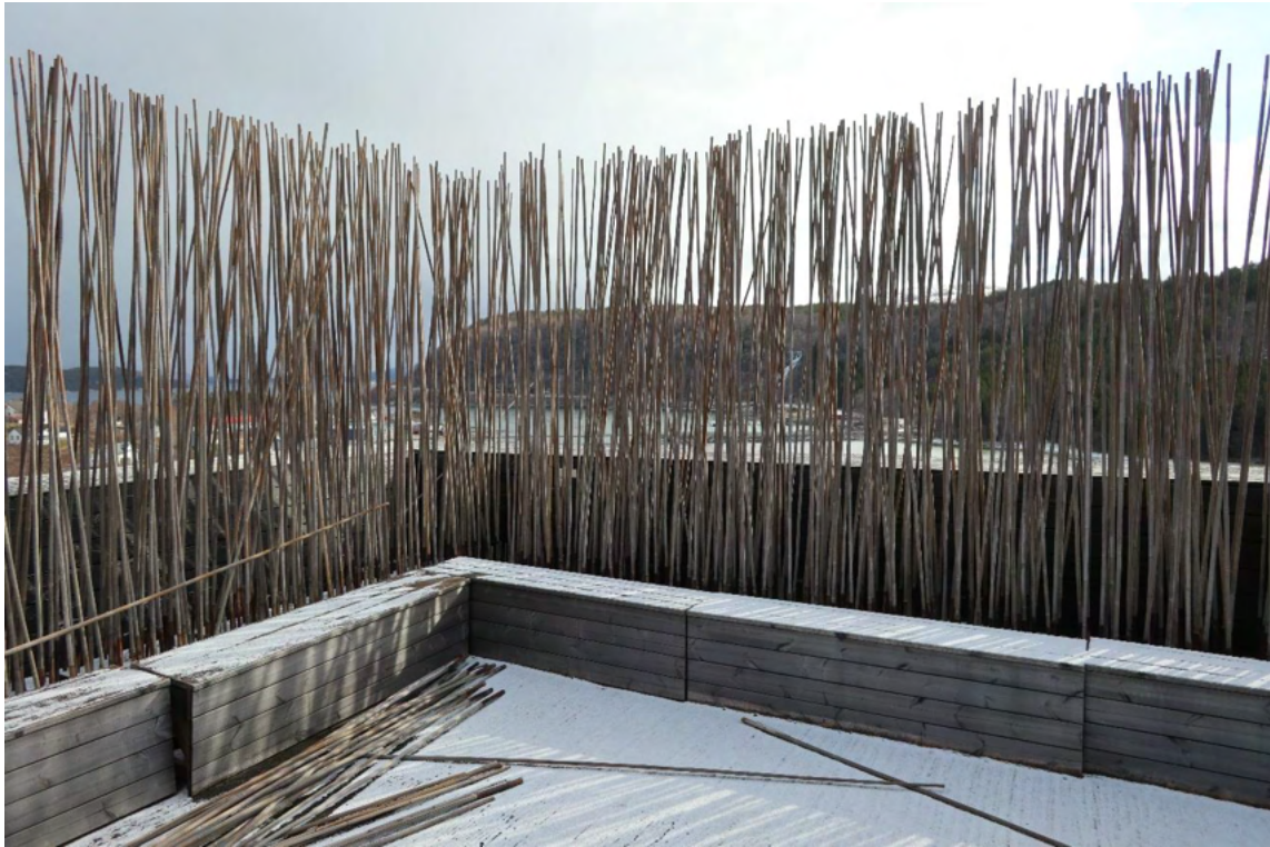
Il. 219. Zaśnieżony taras na ostatniej kondygnacji, z tyczkami bambusowymi („włosami”) tworzącymi ażurowe ściany. Fot. autora, 2022
