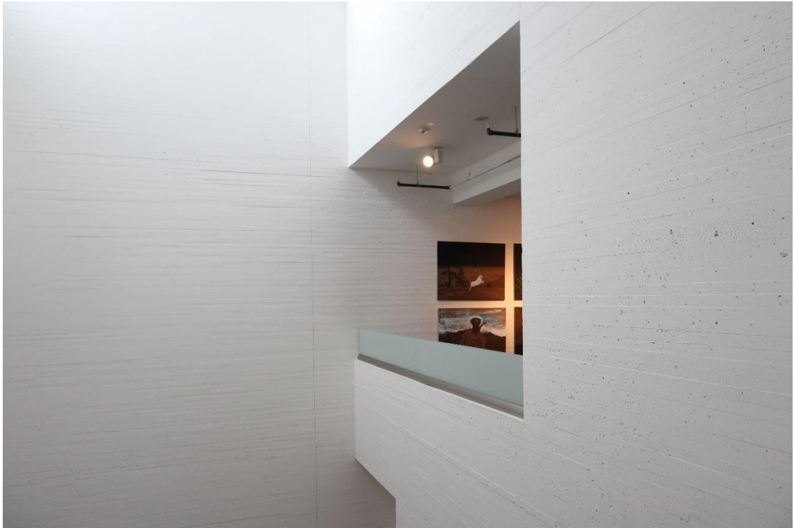
II. 202. Dodatkowy punkt obserwacji, kondygnacja +2. Fot. autora, 2022
