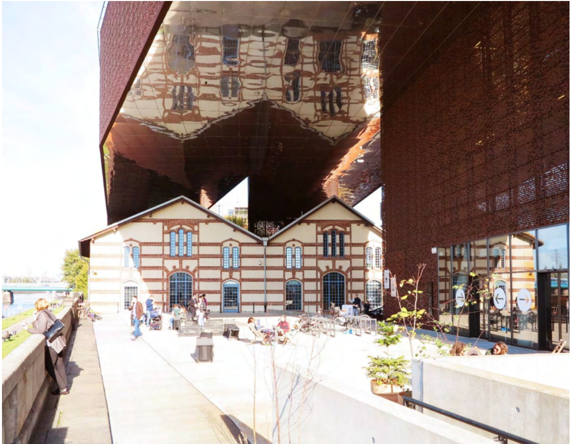
Il. 97. Ośrodek Dokumentacji Sztuki Tadeusza Kantora Cricoteka, odbicie lustrzane dawnej elektrowni. Fot. autora, 2019
