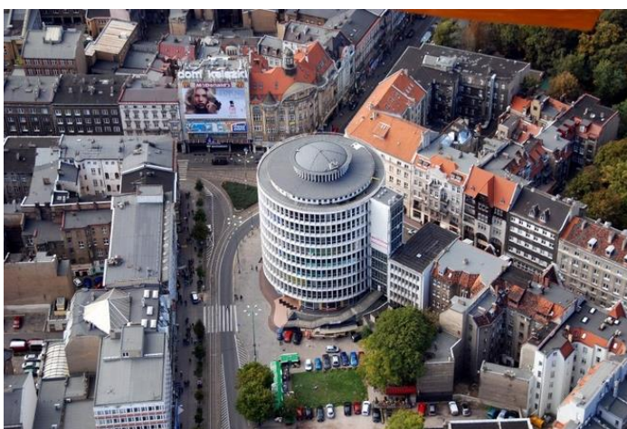
Ryc. 177 arch. Marek Leykam – Dom Towarowy - „Okrągłak” – Poznań – 1949-54r. po gen. remoncie w 2012r. Widok z lotu ptaka
