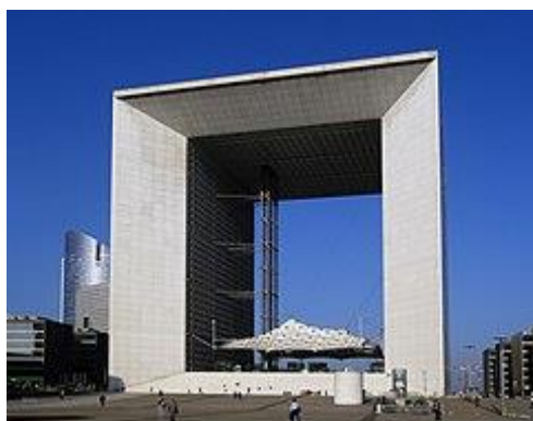
Ryc. 270 arch. Johann Otto von Spreckelsen – Grande Arche de la Défense ( Wielki Łuk Braterstwa ) w Paryżu. Wł. Grande Arche de la Fraternité – 1982-1989r
