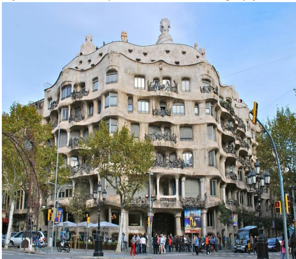
Ryc. 48. arch. Antonio Gaudí - Casa Milà – Barcelona - 1906-1910r.
