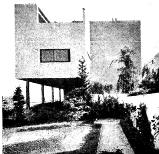
Ryc. 56 Widok od strony północy
