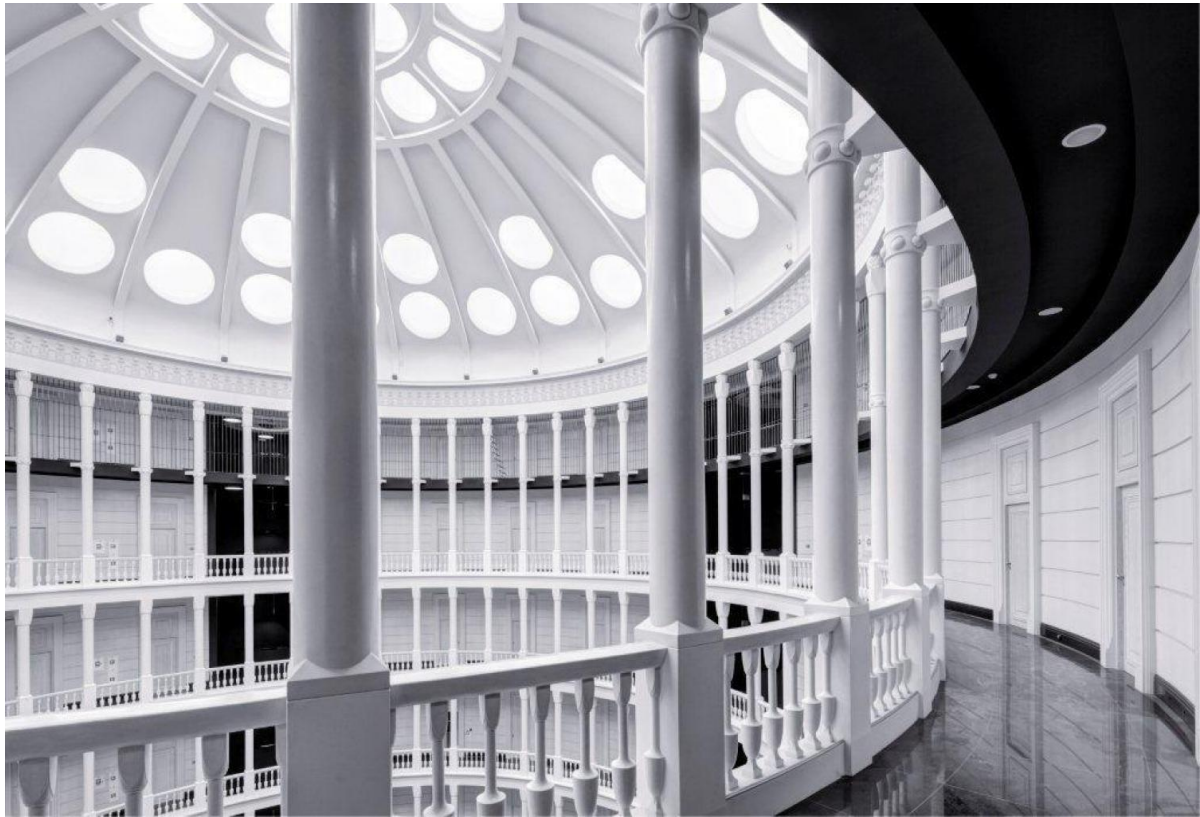
Ryc. 170 arch. Marek Leykam – siedziba Prezydium Rządu – Warszawa – 1952r. - budynek po kapitalnym remoncie – obecnie biurowiec (Jana Kulczyka) - Ufficio Primo .
