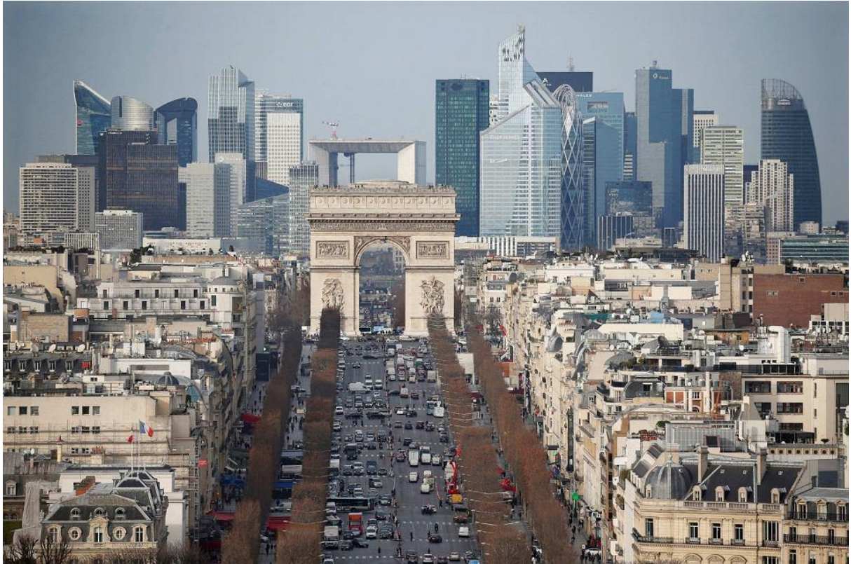
Ryc.272 arch. Johann Otto von Spreckelsen – Grande Arche de la Défense ( Wielki Łuk Braterstwa ) w Paryżu. Zdjęcie z lotu ptaka pokazujące kontekst urbanistyczny lokacji i siłę założenia cytowanej powyżej osi.
