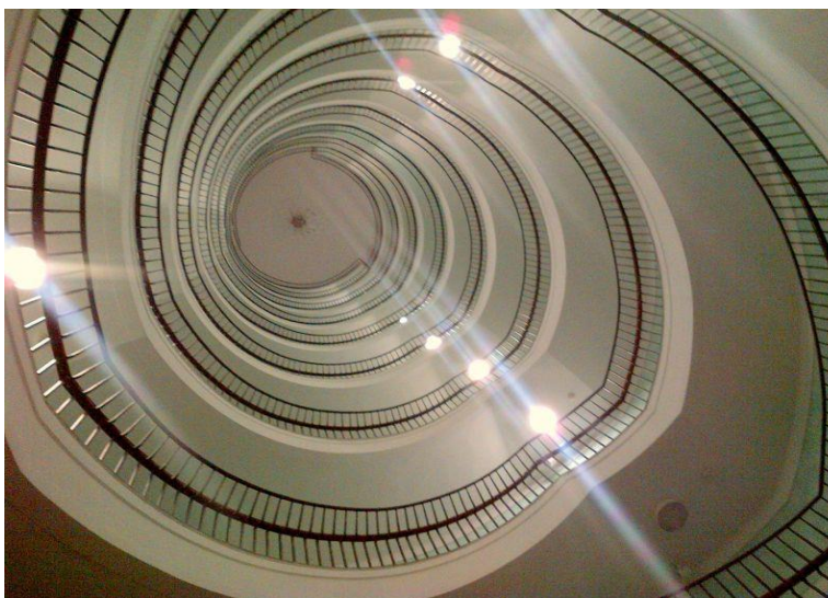
Ryc. 175 arch. Marek Leykam – Dom Towarowy - „Okrągłak” – Poznań – 1949-54r. klatka schodowa
