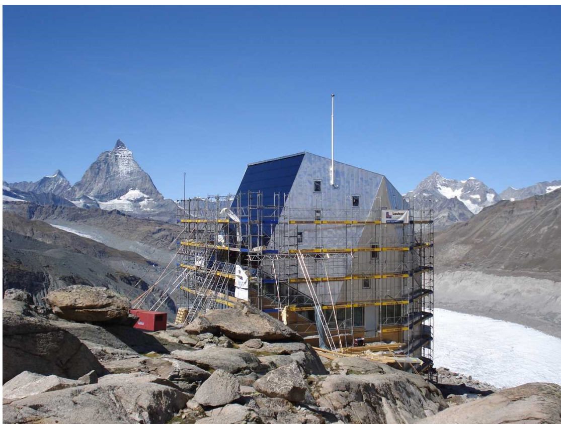
Ilu. 6.38 Prace budowlane po aktualizacji projektu 2010 (Autor: Tonatiuh Ambrosetti, źródło: Int. 27)
