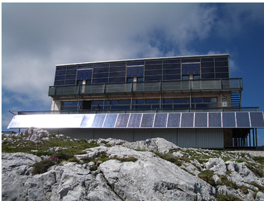
Ilu. 6.5 Kolektory słoneczne i ogniwa fotowoltaiczne zamontowane na budynku schroniska (Autor: nieznanym źródło: Int. 6.3.)
