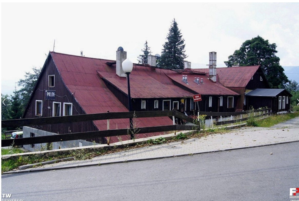
Il. 3.51 Ośrodek Polon (wcześniej schronisko Tannenhofbaude) w Szklarskiej Porębie Górnej, zdjęcie z 2011 roku, widać że przyziemie zostało ocieplone, stolarka okienna wymieniona na PVC ale deskowania pozostały oryginalne (autor: nieznany, źródło: Int. 3.32),
