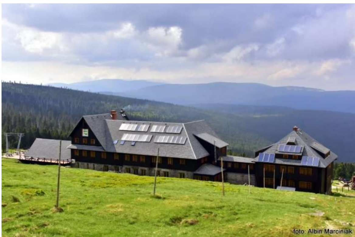
Ilu. 3.43 Schronisko na Hali Szrenickiej po remoncie w 2014 r. Ściany zewnętrzne, renowacja na wysokim poziomie odtworzony charakter budynku pierwotnego. Wymiana pokrycia dachu, wymiana na gont bitumiczny może okazać się równie zgubnym rozwiązaniem co w przypadku schroniska Samotnia. Panele solarne są zainstalowane na dachu, nie dostosowane do geometrii (narożniki paneli wystają ponad boczne połacie) (autor: nieznanym, źródło: Int. 3.30),
