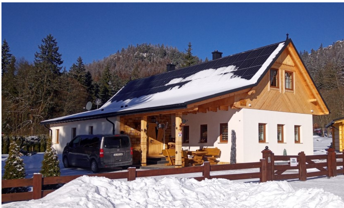
Ilu. 3.48 Budynek pokryty dachem solarnym, pełna pości z paneli fotowoltaicznych, w Kudowie Zdroju (autor: własne, 2023)
