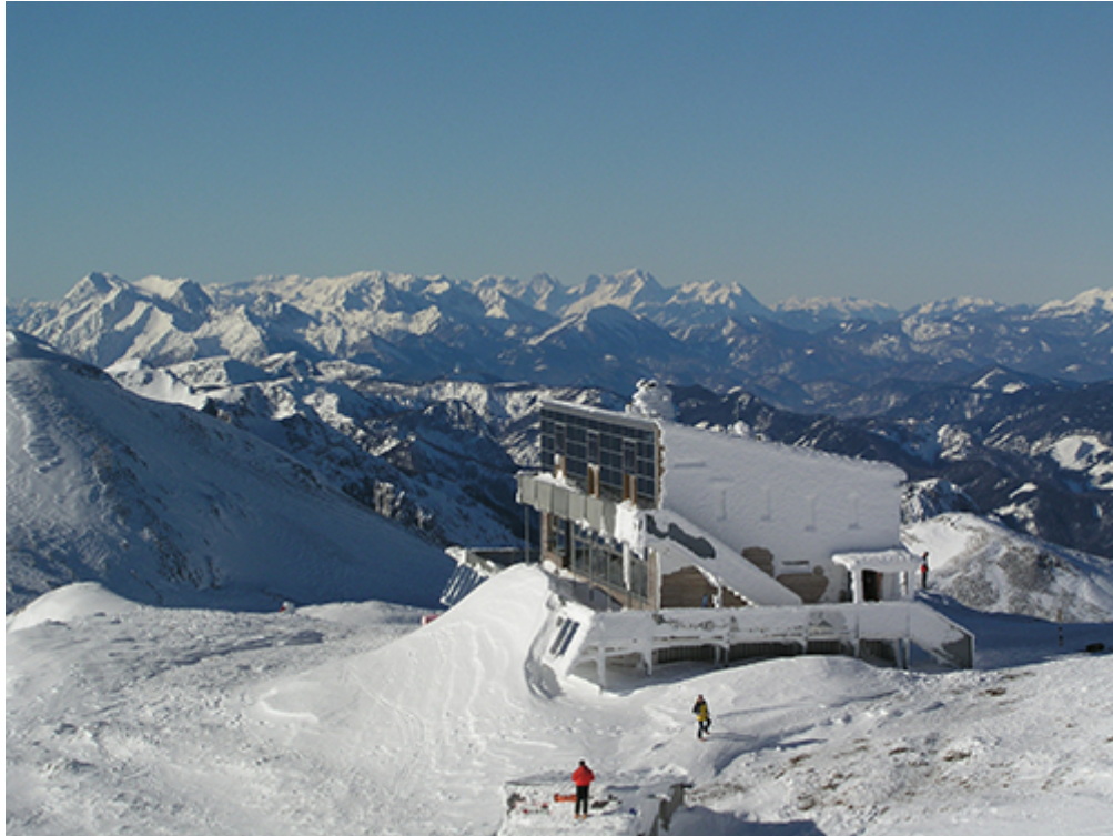
Il. 6.4 Schronisko „Schiestlhaus” odporny na ekstremalne warunki pogodowe budynek górnego schroniska (Autor: nieznanego źródła: Int. 6.3.)
