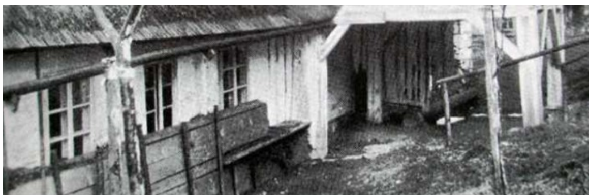
Ilu. 3.32. Zygata na do wysokość parapetu z pełnym deskowaniem zewnętrznym, miejscowość Wyrębnia (stan z 1928 r.)(autor: nieznany, źródło: (35a))
