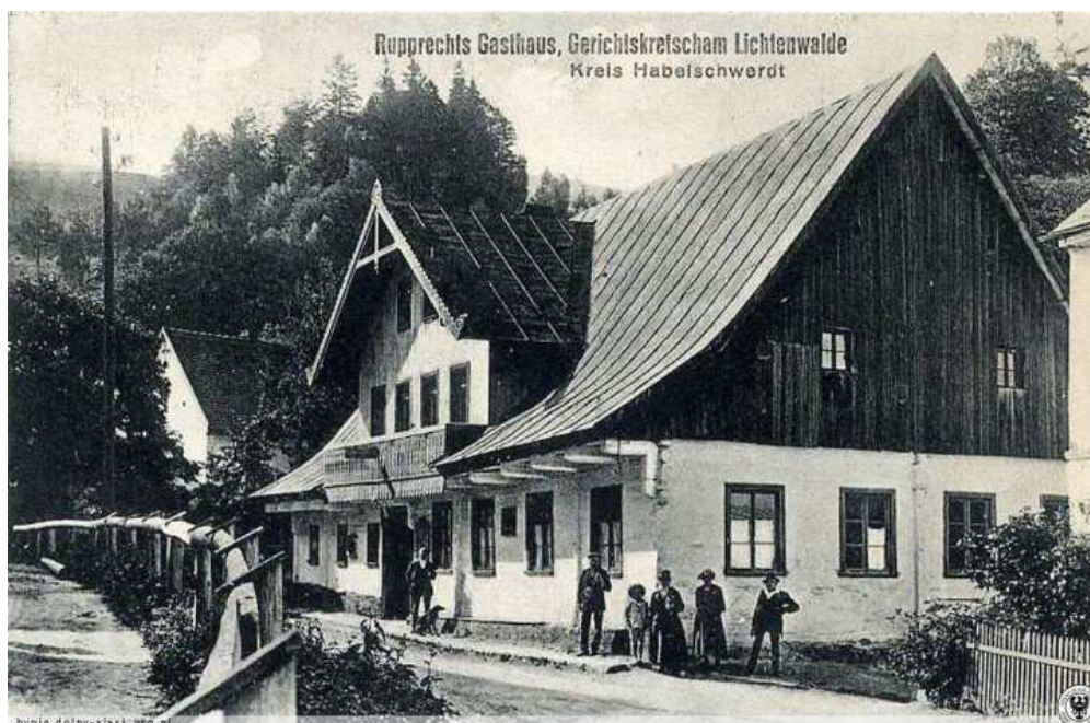
Ilu 3.21. Podcienia frontowe w budynkach: a) zajazdu i karczmy, Poręba, stan z lat 1915–1920 (autor: nieznan, źródło: Int. 3.15);
