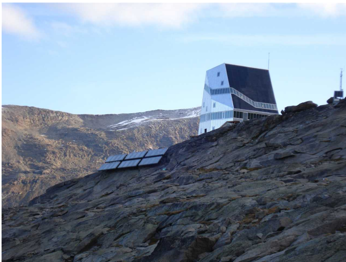
Ilu. 6.39 System fotowoltaiczny zintegrowany z budynkiem, a południowa fasada generuje energię (Autor: Photo @ Markus Gerber, źródło: Int. 25)
