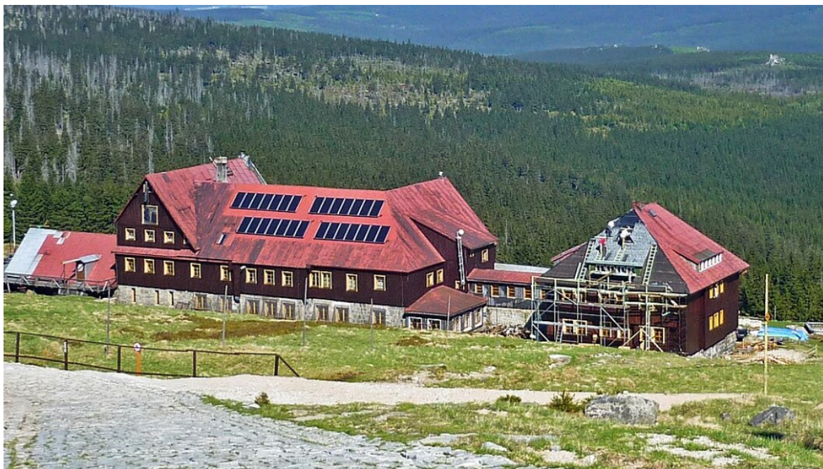
Ilu. 3.42 Schronisko na Hali Szrenickiej w trakcie remontu w 2014 r. Widoczne jest że już wcześniej zostały (na starej połaci dachu) zainstalowane panele fotowoltaiczne które jeszcze bardziej niż po remoncie przykuwają uwagę. (autor: SchiDD, źródło: Int.2.29),
