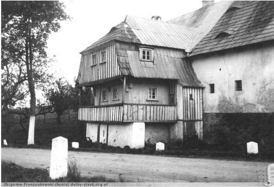
Ilu 3.27. Wystawki z wyżkami o konstrukcji wieńcowej, pokryte deskowaniem na zakładkę w układzie pionowym: a) nakryta dachem dwuspadowym z kozubkiem, karczma sądowa, Długopole Górne, stan z lat 1903–1913 (29) z obejściem w formie galerii wysuniętej (typu balkon), nakryta dachem mansardowym z kozubkiem, budynek mieszkalno–gospodarczy, Nowa Bystrzyca, stan z lat 1935–1940 (autor: nieznany, źródło: Int. 3.19);
