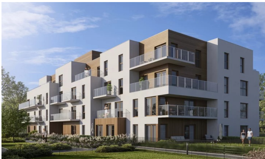
Ilu. 4.44 – Apartamentowce (projekt) w Kudowie Zdroju (autor: nieznane, źródło: int 4.5)
