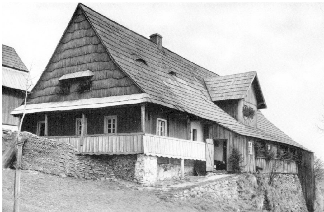
Ilu 3.13. Budynki mieszkalno gospodarcze ze szczytami pokrytymi zachodzącymi na siebie rzędami gontu, Spalona, stan z lat 1938–1940 (17)
