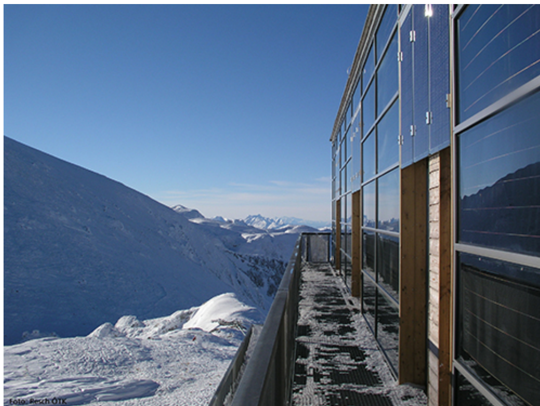
Ilu. 6.46 Schronisko Schiestlhaus, - przeszklenia od strony południowej (Autor: Posarchitekten, źródło: Int. 31)
