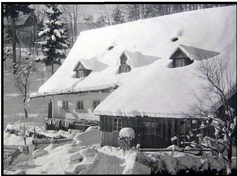
Ilu. 3.8. Lukarny doświetlające poddasze w budynkach mieszkalno gospodarczych z: dachem dwuspadowym, Wójtowice, stan z lat 1930–1935 (autor: nieznany, źródło: Int. 3.8)
