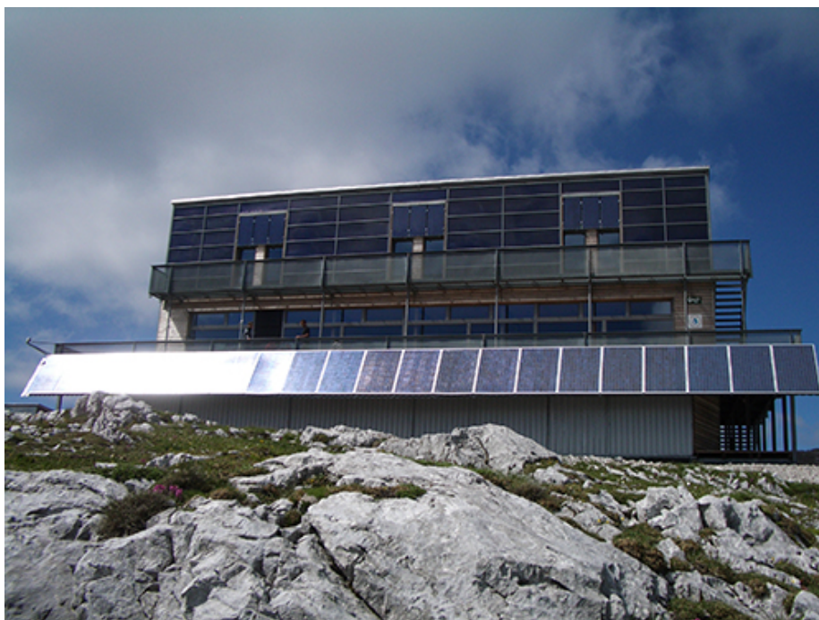
Ilu. 6.47 Schronisko Schiestlhaus, - Ogniwa fotowoltaiczne zamontowane na budynku (Autor: Posarchitekten, źródło: Int. 31)
