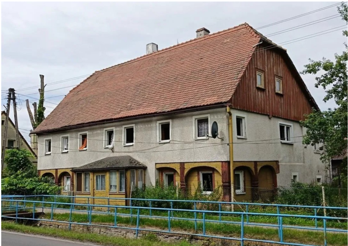
Ilu. 3.37 Dom przysłupowy w Opolnie Zdroju, z widocznym ociepleniem ścian 1 piętra i murowanej części przyziemia. Stolarstwo okienne wymieniono w całości na PVC, osadzone w głębi (wynik ocieplenia) i bez historycznych podziałów (autor: nieznanany, źródło: Int.3.24),
