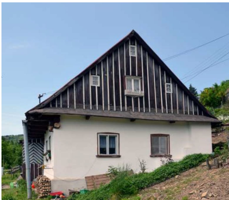
Ilu. 3.17. Budynki mieszkalno–gospodarcze z okapami szczytowymi (daszkami przyzbowymi): z desek, wspartych o rysie i mocowane prostopadłe do belki stropowej, belki wsporcze, Nowa Bystrzyca, stan z 2017 r. (autor: Jarosz M. T, źródło: (2));
