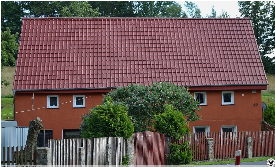
Ilu. 3.35 Budynek mieszkalno–gospodarczy w Lwówku Śląskim, termomodernizacja ścian na całej wysokości, tynkowanie i dobór kolorystyczny tak jak blacho dachówka bez odniesienia do tradycji regionalnej. Powiększone otwory okienne w przyziemiu i stolarka okienna wymieniona w całości na PVC, bez historycznych podziałów. Całkowicie odmieniony charakter budynku. (autor: nieznanym, źródło: Int.3.22),
