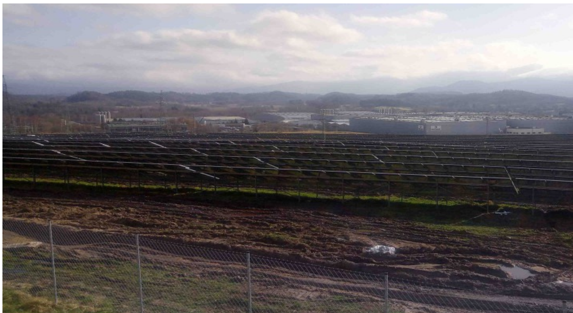
Il. 3.49 Ferma fotowoltaiczna przy drodze do Szklarskiej Poręby (autor: własne, 2024)
