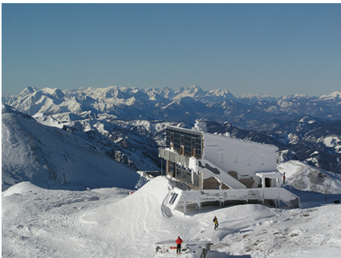
Ilu. 6.45 Odporny na ekstremalne warunki pogodowe budynek górskiego schroniska (Autor: ÖTK, źródło: Int. 31)
