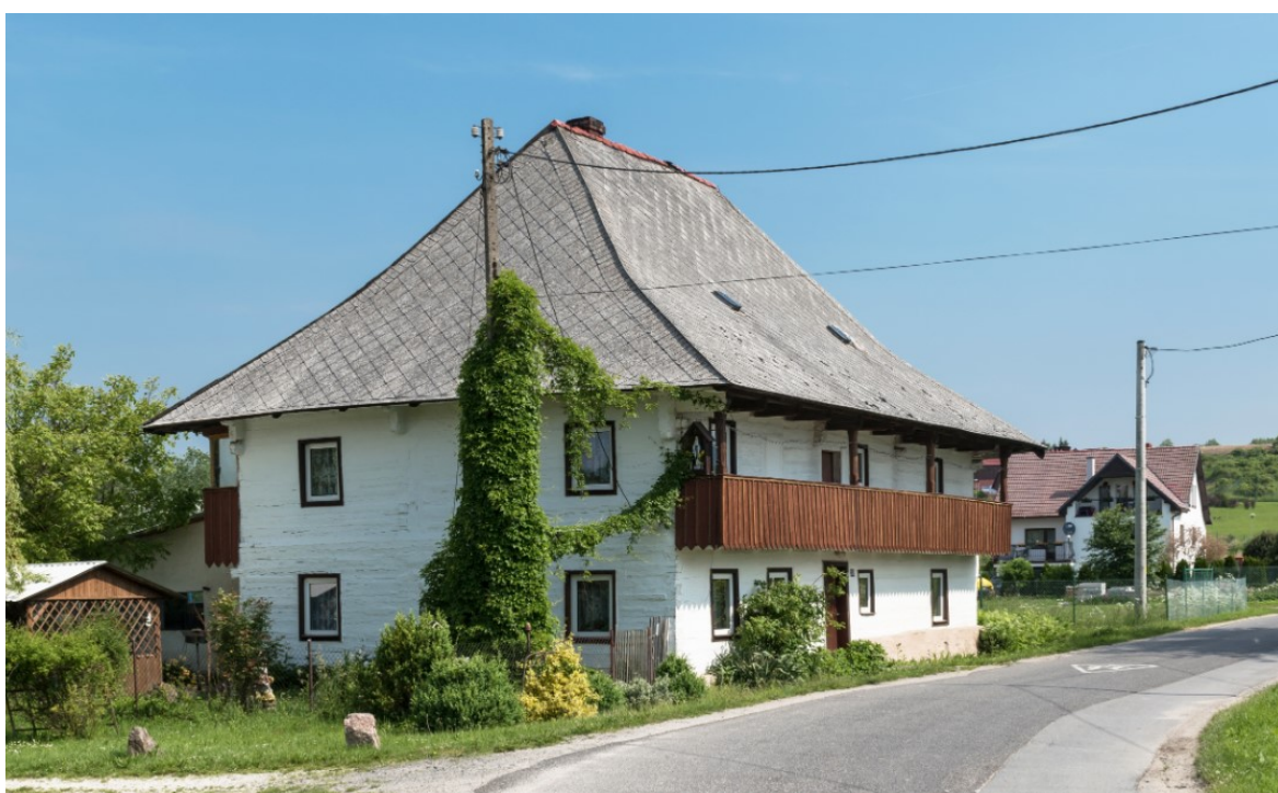
Ilu. 3.39 Budynek mieszkalny w Wilkanowie, ogólny charakter budynku zachowany ale stolarka okienna wymieniona w całości na PVC, bez historycznych podziałów; (autor: nieznany, źródło: Int.3.26),
