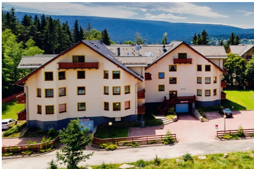
Ilu. 4.43 – Apartamentowce z lat 2000 (autor: nieznane, źródło: int 4.4)
