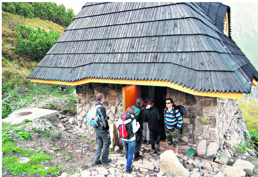
Ilu. 6.75 Budynek techniczny oczyszczalni ścieków (Autor: nieznane, źródło: Int. 46)
