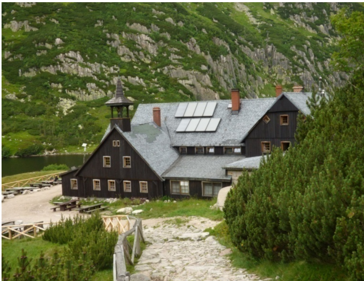
Ilu. 6.78 Schronisko Samotnia kilka lat po remoncie pokrycia dachu i instalacji fotowoltaiki (Autor: własne,)
