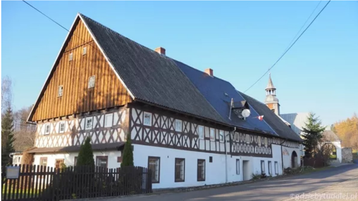
Fot. 3.6. Szachulcowy dom w Bukowcu (autor: gdziebytudalej, źródło: Int. 3.5)
