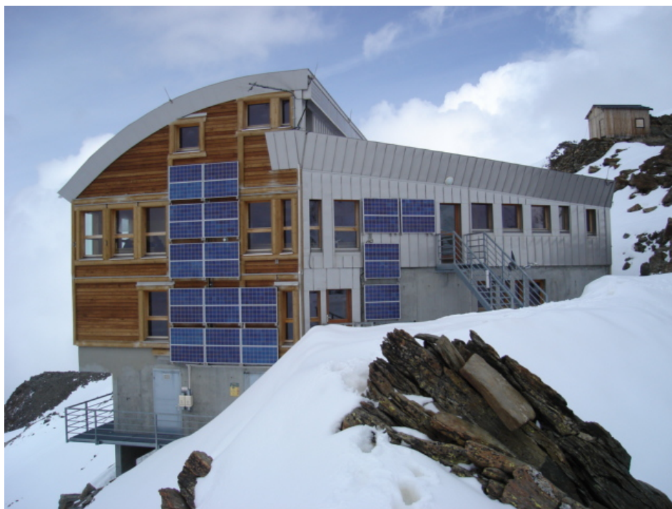
Ilu. 6.67 Schronisko Refuge de TeteRousse- panele fotowoltaiczne na południowej elewacji (Autor: nieznany źródło: Int. 41)
