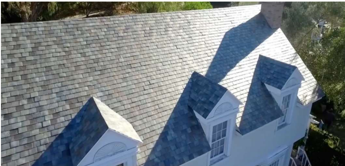
Ilu. 6.11 Widok dachu solarnego pokrytego „łupkiem” (Autor: Tesla, źródło: Int. 6.8.)
