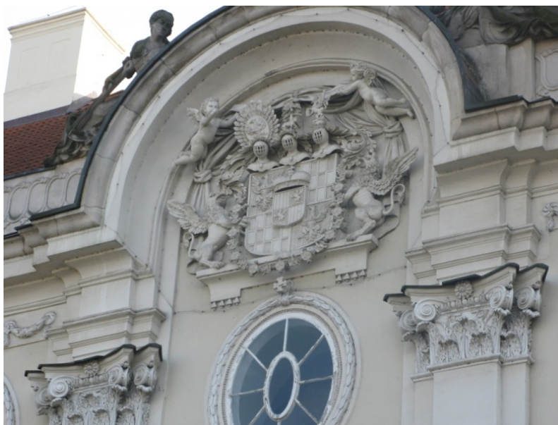
Ilu. 4.9 - Herb Schaffgotschów na frontonie pałacy w Cieplicach zawierający elementy saskie i piastowskie (autor: własne, 2021)
