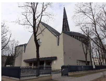
Rys 23-1. Kościół pw. Najświętszego Serca Pana Jezusa (widok 1)
