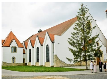
Rys. 66-1. Kościół pw. Najświętszego Serca Pana Jezusa (widok 1)
