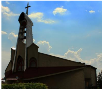
Rys 37-1. Kościół pw. Św. Brata Alberta Chmielowskiego (widok 1)
