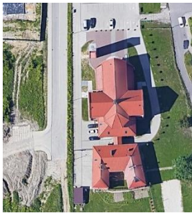
Rys. 27-3. Kościół pw. Św. Rafała Kalinowskiego (widok z góry)
