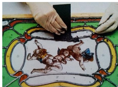
Fot. 80. Kitowanie - Witraż tradycyjny
