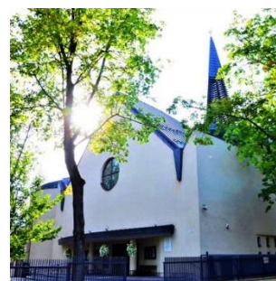
Rys 23-2. Kościół pw. Najświętszego Serca Pana Jezusa (widok 2)
