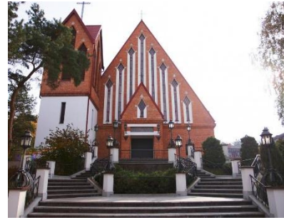
Rys 35-2. Kościół pw. Najświętszego Ciała i Krwi Chrystusa (widok 2)
