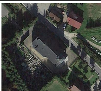
Rys. 64-3. Kościół pw. Imienia Maryi (widok z góry)
