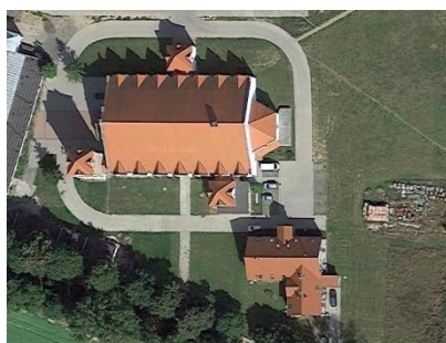
Rys. 66-3. Kościół pw. Najświętszego Serca Pana Jezusa (widok z góry)
