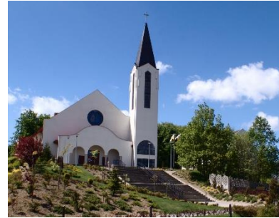
Rys. 56-2. Kościół pw. Św. Trójcy (widok 2)
