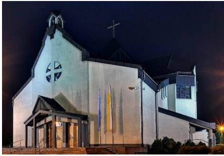
Rys. 92-1. Kościół pw. Najświętszego Ciała i Krwi Chrystusa (widok 1)
