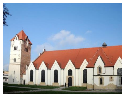
Rys. 66-2. Kościół pw. Najświętszego Serca Pana Jezusa (widok 2)
