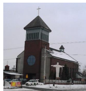
Rys. 58-2. Kaplica pw. Bł. Męczenników (widok 2)
