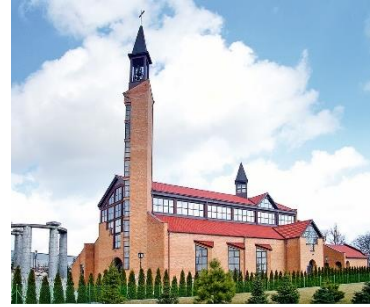
Rys. 79-2. Kościół pw. NMP Matki Kościoła (widok 2)
