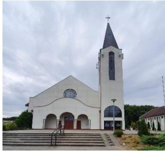
Rys. 56-1. Kościół pw. Św. Trójcy (widok 1)
