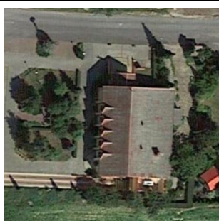
Rys. 87-3. Kaplica pw. Św. Brata Alberta (widok z góry)
