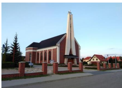
Rys. 73-1. Kościół pw. Św. Faustyny (widok 1)
