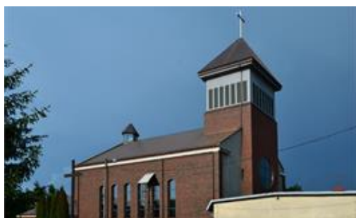
Rys. 58-1. Kaplica pw. Bł. Męczenników (widok 1)
