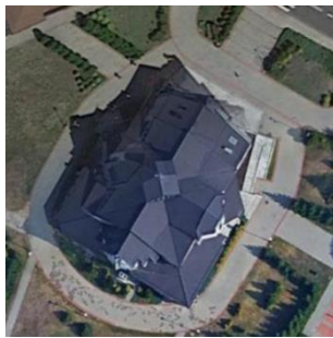
Rys. 92-3. Kościół pw. Najświętszego Ciała i Krwi Chrystusa (widok z góry)
