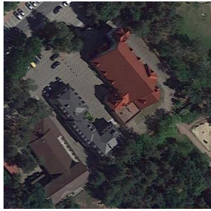
Rys. 35-3. Kościół pw. Najświętszego Ciała i Krwi Chrystusa (widok z góry)
