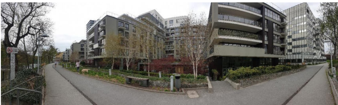
Il. 29 Budynek Angel Wings od strony wybrzeża Oławy, fot. własna (2022).
