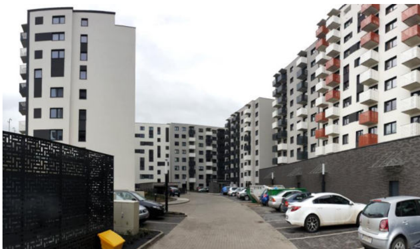
Il. 42 Wnętrze kwartału Kamienna 145 (M19), fot. własna (2022).
