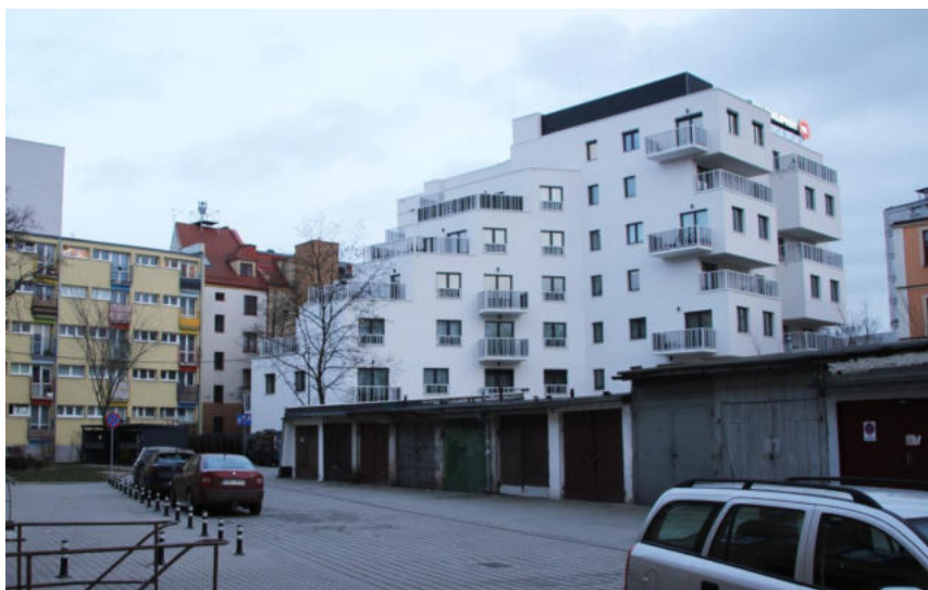
Il. 46 Budynek Grabiszyńska 141 (M10) widziany od strony podwórka, fot. własna (2022).
