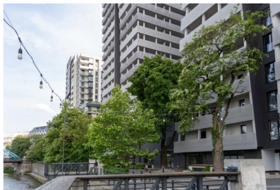
Ilustracja 37 Drzewa chronione w planie – zbyt mała odległość od elewacji budynku, zdjęcie: Grzegorz Rajter
