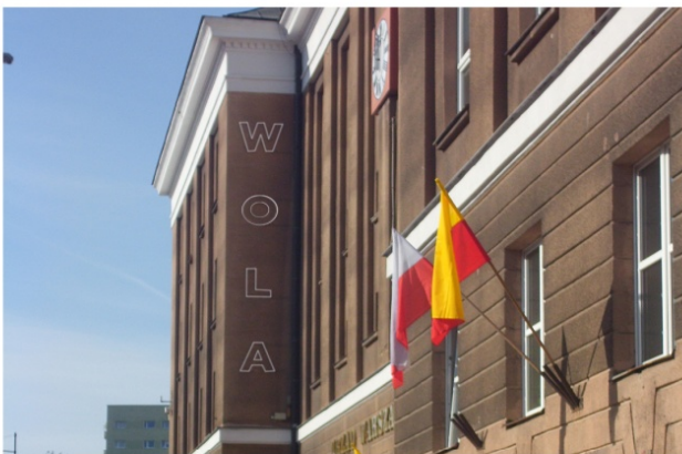
Neon na fasadzie głównej wspomagający identyfikację obiektu
