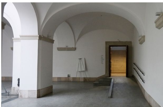
Zróżnicowane kolory powierzchni ścian, posadzki, listew podłogowych, stolatki drzwiowej oraz poręczy
