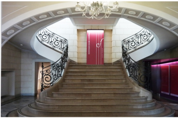
Stopnie schodów znaczone ciemnymi, kontrastującymi taśmami
