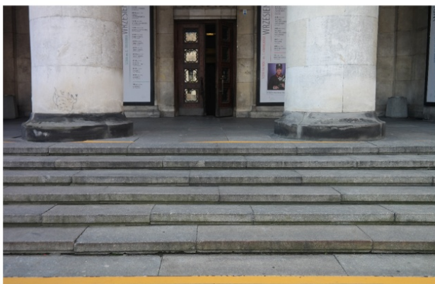
Wyraźne, kontrastujące linie oznaczające początek oraz koniec schodów
