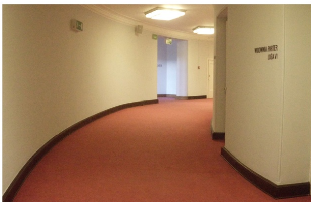
Czerwony kolor posadzki w strefie dla gości, posadzka ze spadkiem - swobodne wejście do sali głównej na różnych poziomach
