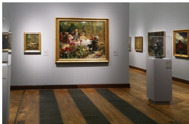
Zastosowany system ogrzewania podłogowego, kratki wentylacyjne wyrównane do poziomu posadzki sali
