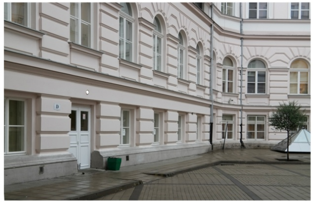
Pochylnia umożliwiająca znalezienie się na poziomie krawężnika
