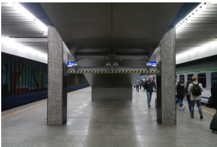
Zdj. 07 Oznaczenie przestrzeni pod schodami o wysokości mniejszej niż 220 cm
