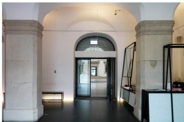
Brak progów. Posadzka chodnika, strefy wejściowej oraz atrium na jednym poziomie. Odpowiednia wysokość lady informacji
