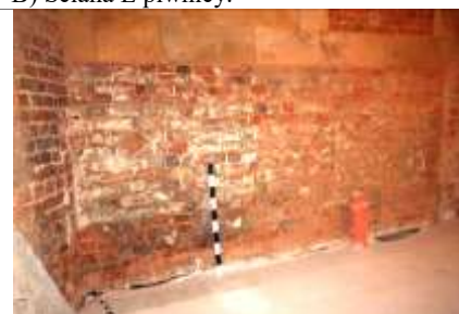
C) Ściana S. Widok w kier. SW.
