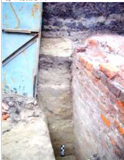
c) Nawarstwienia po N stronie muru.
