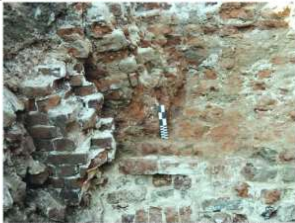
Ryc. 44 (fot. 8). Wrocław, ul. Piotra Skargi, wykop II/2001, widok na styk trzech faz budowy muru obronnego.
