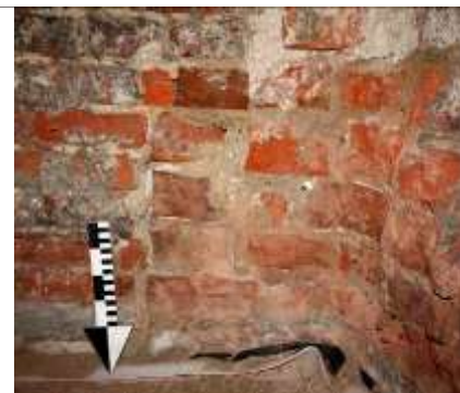
B) Ściana E piwnicy.
