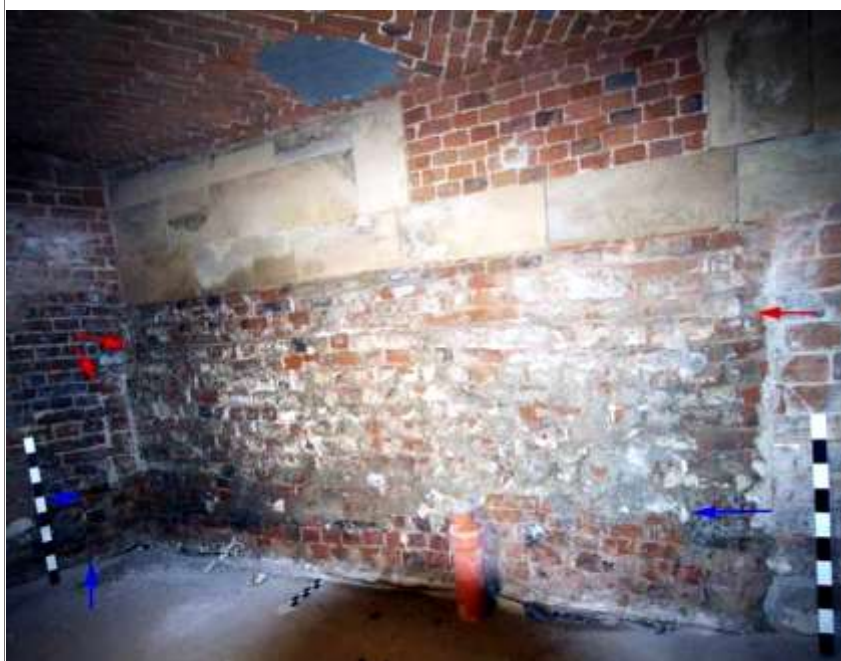
A) Ściana S piwnicy.
