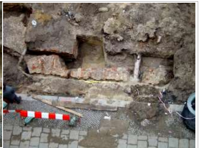
b) Widok w kier. S na basztę i odcinek W muru obronnego.
