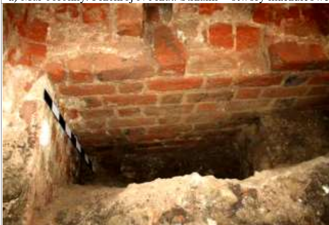
c) Mur obronny. Widok N. Pomieszczenie nie ksponowane.
