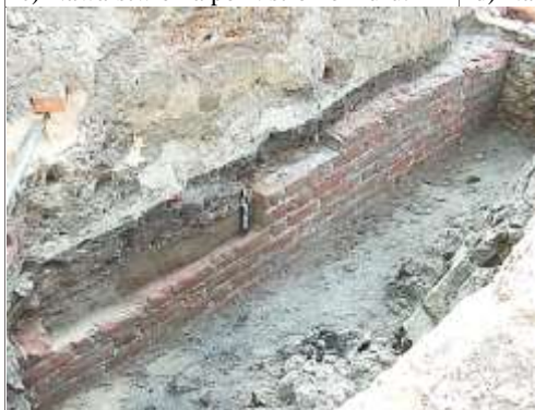
f) Północne lico kurtyny muru bastionowego.
