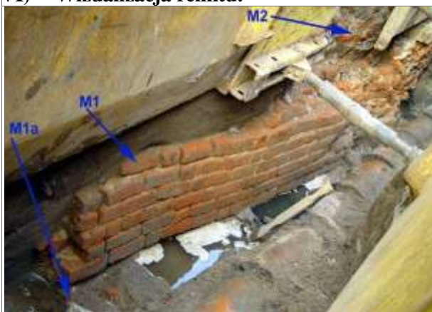
a) Widok SW północnego przyczółka mostowego.
