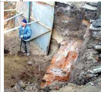
h) Wykop w ul. Teatralnej i mur renesansowy po prawej
